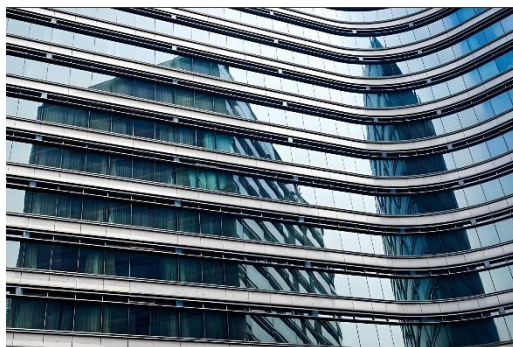
(b) 高层建筑玻璃幕墙
