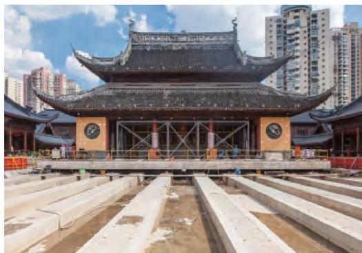
图 1.2 玉佛禅寺大雄宝殿整体移位工程
