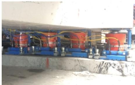
图 1.13 交替式步履行走器移位
