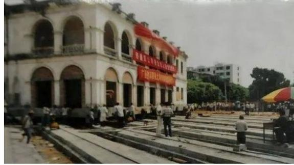
图 1.7 北海市原英国领事馆平移工程
