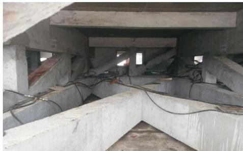
图 4.2 移位工程托换结构
