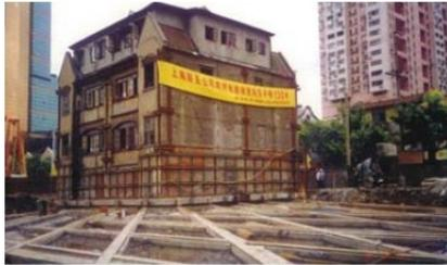
图 1.8 刘长胜故居平移工程
