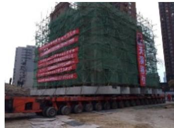
图 1.12 SPMT 自行式平板拖车移位
