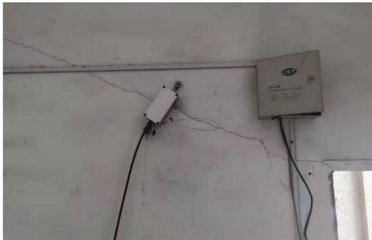
图 2.25 华东医院顶升过程裂缝测点
