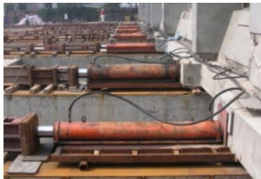
图 1.11 滑轨顶推平移
