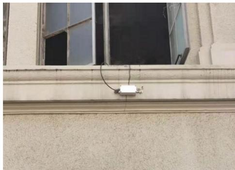
图 2.26 裂缝测点现场图
