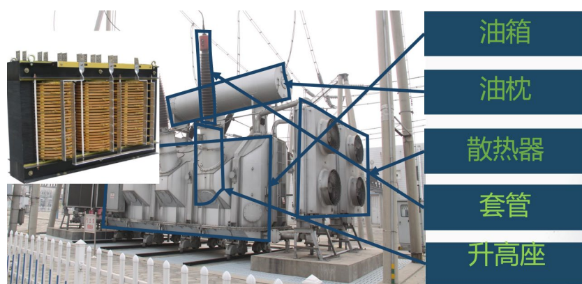
图 1.3 大型变压器结构图
