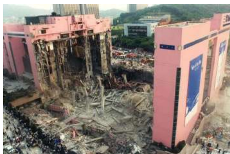
(a) 韩国三丰百货大楼坍塌
