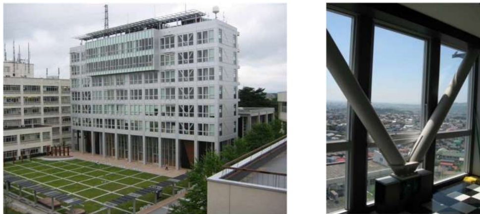
(a) 钢框架结构实景图
