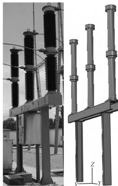
图1 110 kV 断路器及其有限元模型
