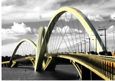
(a) 大跨度桥梁
