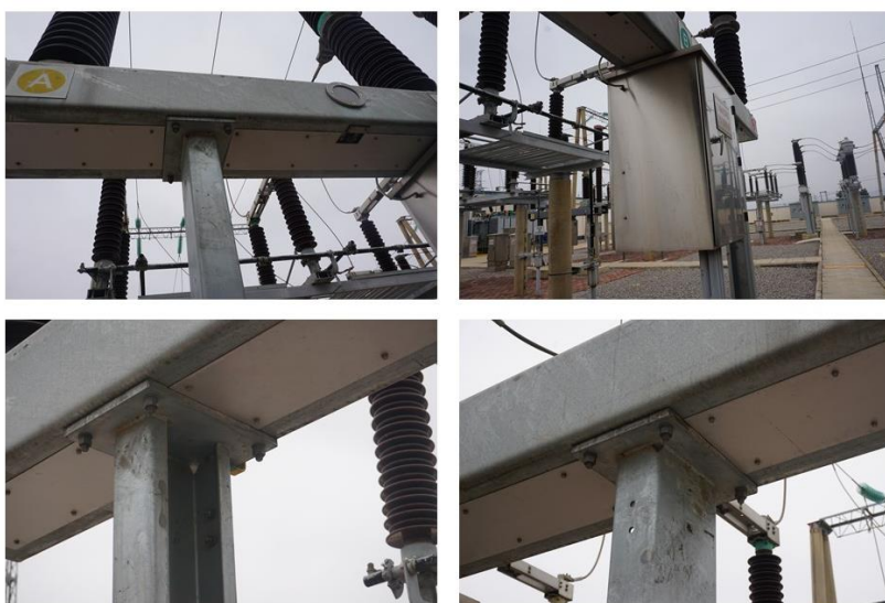
图 2.4 断路器钢支架细节图
