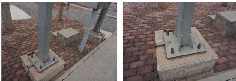
图 2.3 断路器混凝土基础细节图
