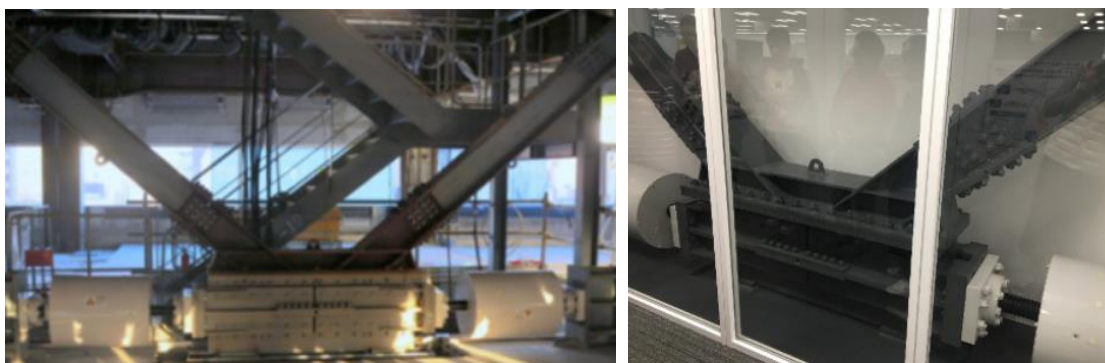
图 1.3 首个利用惯容系统的土木工程结构——日本仙台 NTT 公司大楼 [31]
