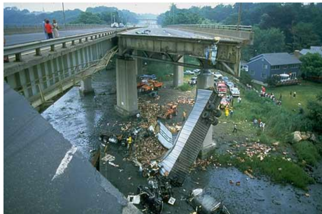
图 1.3 美国康涅狄格州-米勒斯大桥坍塌
