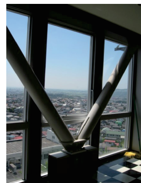
图3 油阻尼器支撑系统
