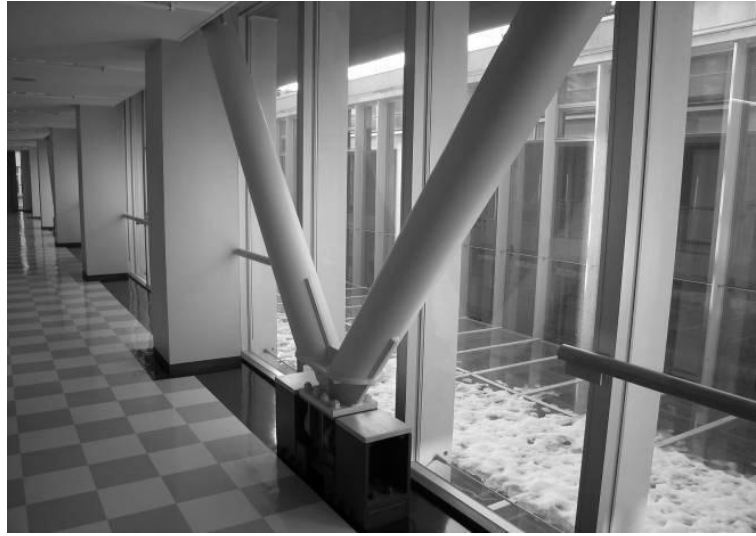
图 5.2 一层油阻尼器安装示意图
