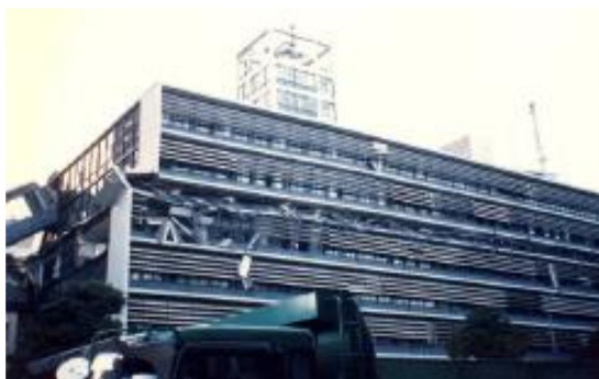
图 1.11 日本阪神地震神户市政厅结构层屈服破坏 [87]
