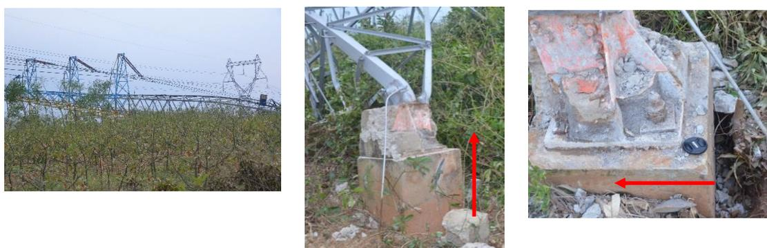
图 1.5 基础薄弱引起的塔体倾覆
