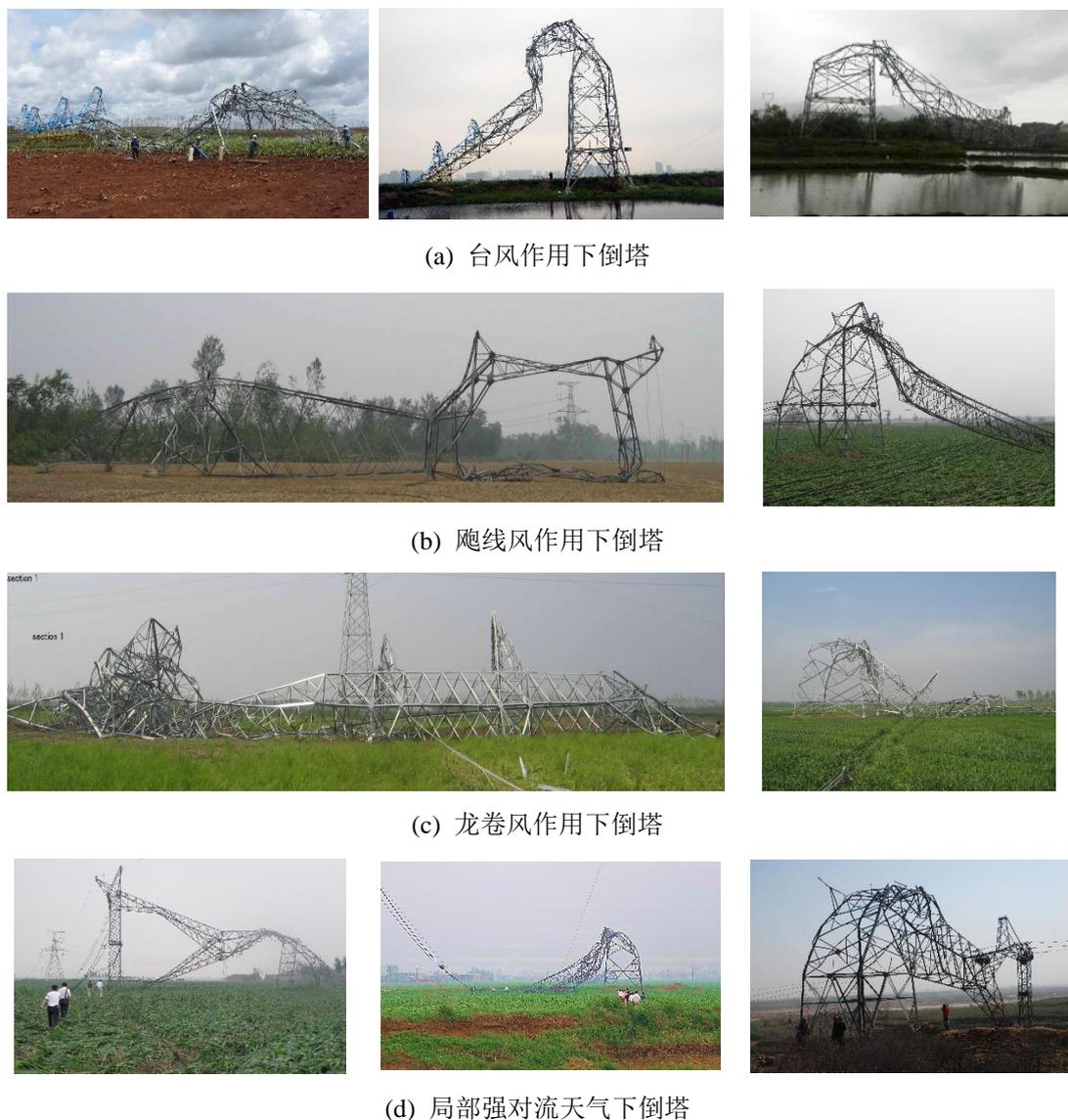
图 1.1 强风作用下输电塔倒塌破坏
