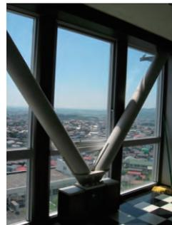
图2 油阻尼器支撑系统
