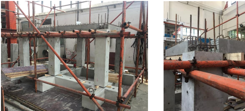
图 3.9 试验室预制构件装配过程
