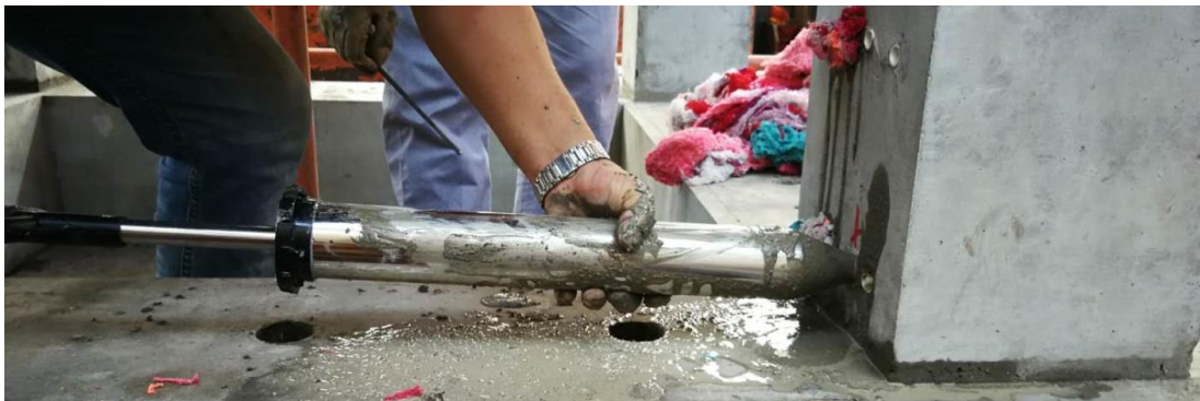
图 3.10 套筒灌浆过程
