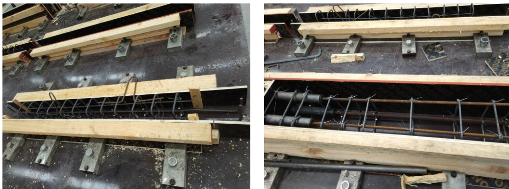
(a) 预制梁钢筋及支模
