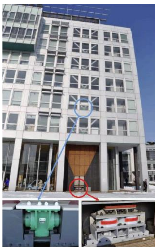
图 2.6 加固后的行政楼
