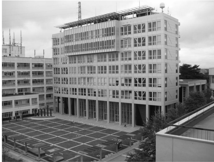
图 2.1 日本东北工业大学的钢结构行政楼
