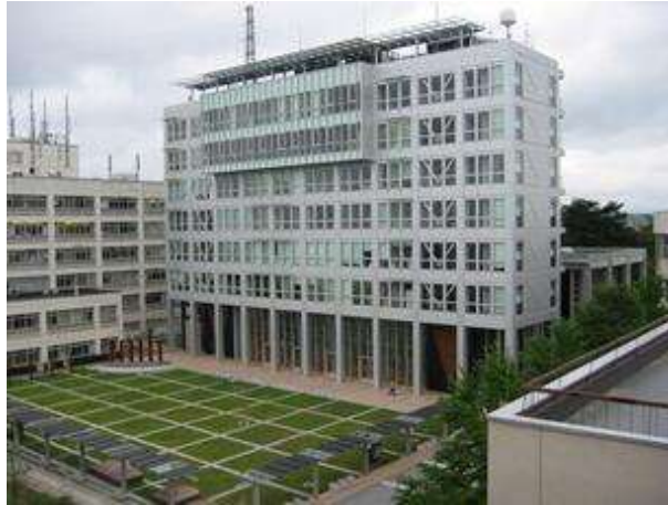
(a)消能减震结构外观
