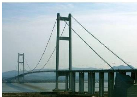
(b) 润扬长江公路大桥
