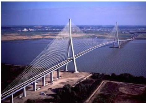
(a) 法国诺曼底大桥
