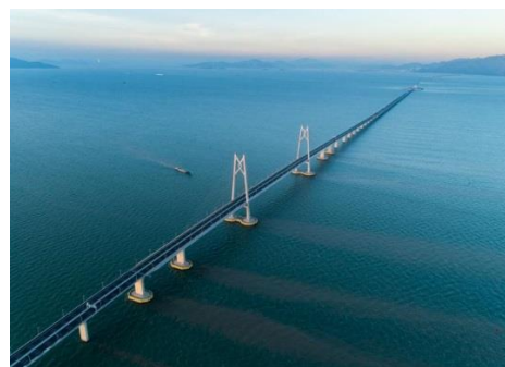
(d) 港珠澳大桥
