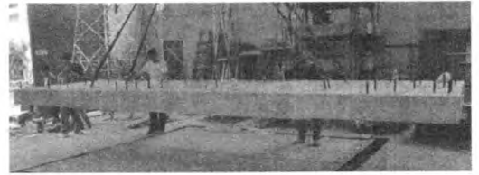
图 7 底座 Fig. 7 The concrete base
