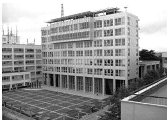
图1 位于日本仙台的油阻尼器钢结构行政楼
