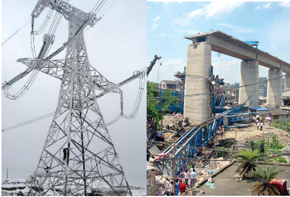
图1.1 2008年雪灾地震台风对构筑物造成的破坏
