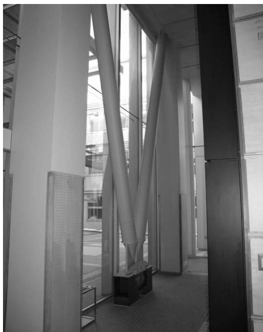
图 2.3 一层油阻尼器（东西向）
