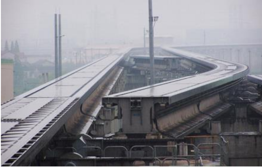
图 1.2 上海磁浮低速道岔
