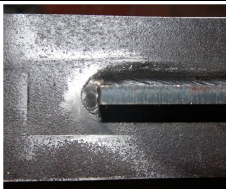
(b) 加劲肋端部焊缝光滑处理
